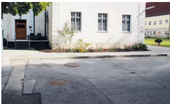
Der Parkplatz vor dem Priesterhaus soll ertüchtigt werden. Noch fehlt auch die Eingangsrampe links vom Priesterhaus.
