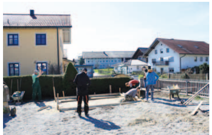
Das Foto zeigt die Firmgruppe bei den Fundamentarbeiten im Eckergarten.
