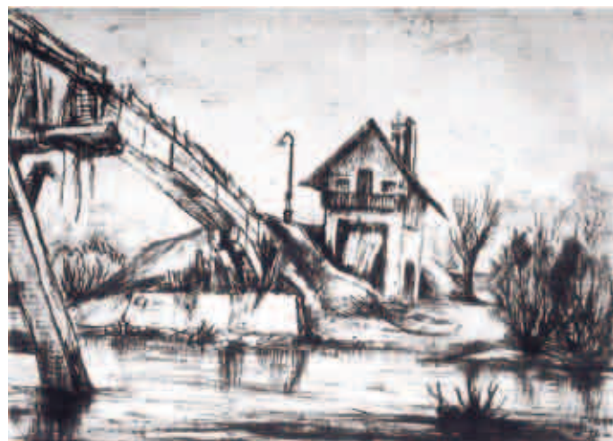
Die Holzbrücke über den Inn nach der Sprengung im Mai 1945. Rohrfederzeichnung von 1946 von Albrecht Hohlt (Quelle: Jahrbuch 1994/95 des Heimatvereins Wasserburg und Umgebung e.V.)
